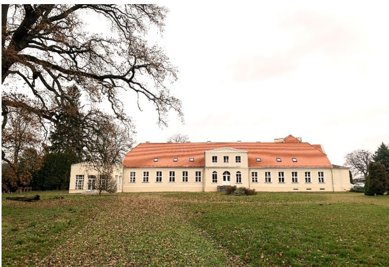
Im Rahmen des Projektes renoviertes Konferenz- und Bildungszentrum der Universität Stettin im Dorf Kulice im ehemaligen Gutshaus der Familie von Bismarck
